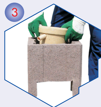
3 Postaviti prvi plašt na mort i u sredinu uložiti kondenzacijsku posudu.
