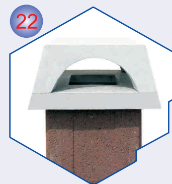
21 Na mort montirati završnu betonsku kapu.
