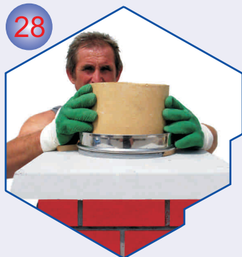
Izmjeriti potrebnu visinu zadnje cijevi do visine konusnog završetka, istu odrezati i ugraditi je kroz prsten završne ploče.
