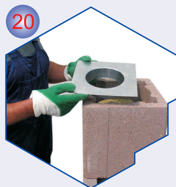
20 Ugraditi diletacijsku rozetu.
