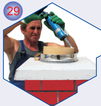
Na rubove cijevi nanijeti isporučeni silikon.
