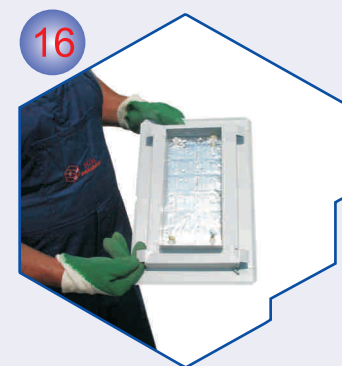
16 Limena vrata montirati na priključak za vrata.
