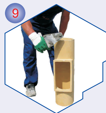
9 U plašt na kondenzacijsku posudu ugraditi priključak za vrata.
