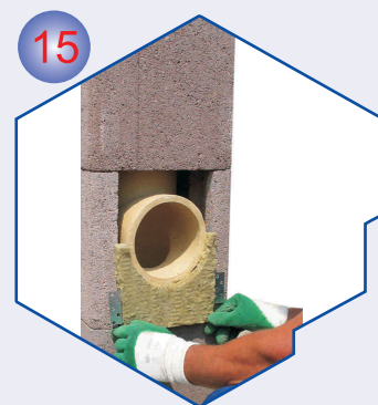
15 Na otvore oko priključka montirati tervol ploču.
