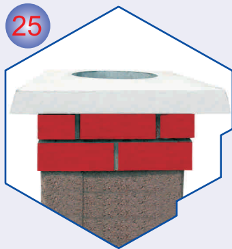
Na ljepilo postaviti završnu ploču.
