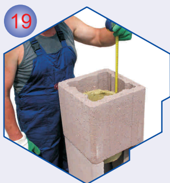
19 Zadnju cijev izrezati 3 cm niže od razine zadnjeg plašta.
