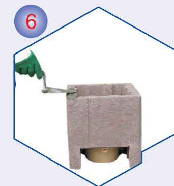
6 Kod nastavka zidanja na plašt nanijeti mort, a na rubove kondenzacijske posude kit za spajanje.
