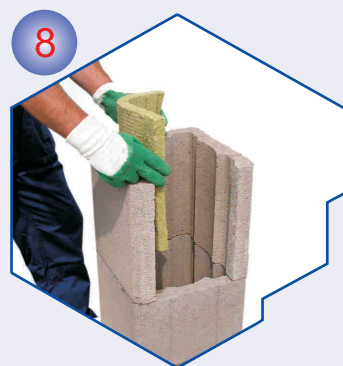
8 Plašt staviti na nanoseni mort, te postaviti izolaciju.
