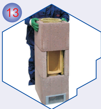
13 Na donji plašt nanijeti mort i postaviti sljedeći plašt.
