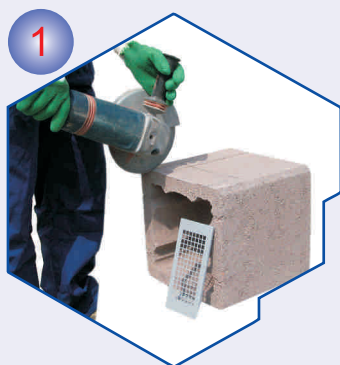
1 Dimnjak se počinje zidati na pripremljenu podlogu visine gotovog poda. Na prvom plaštu izrezati otvor za ventilacijsku rešetku.
