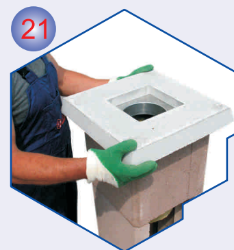
21 Na mort montirati završnu betonsku kapu.
