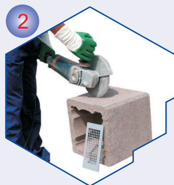
1 Dimnjak se počinje zidati na pripremljenu podlogu visine gotovog poda. Na prvom plaštu izrezati otvor za ventilacijsku rešetku.
