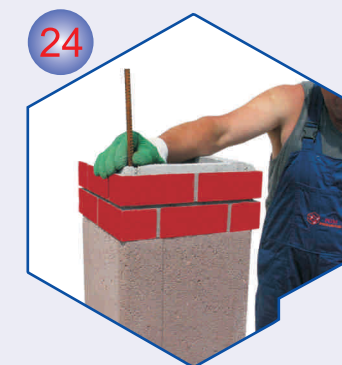
24 Nakon potrebne visine završne elemente armirati.
