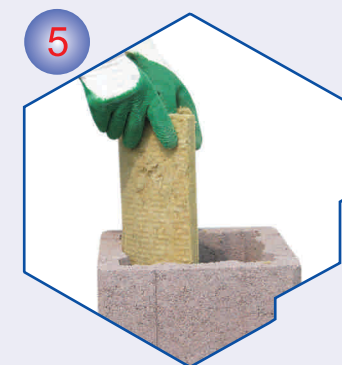
5 Postaviti tervol ploče i odrezati ih u visini plašta.
