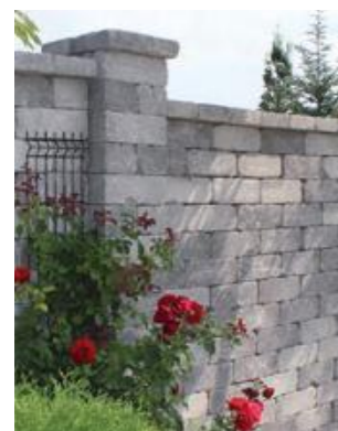
Zidovi i ograde
